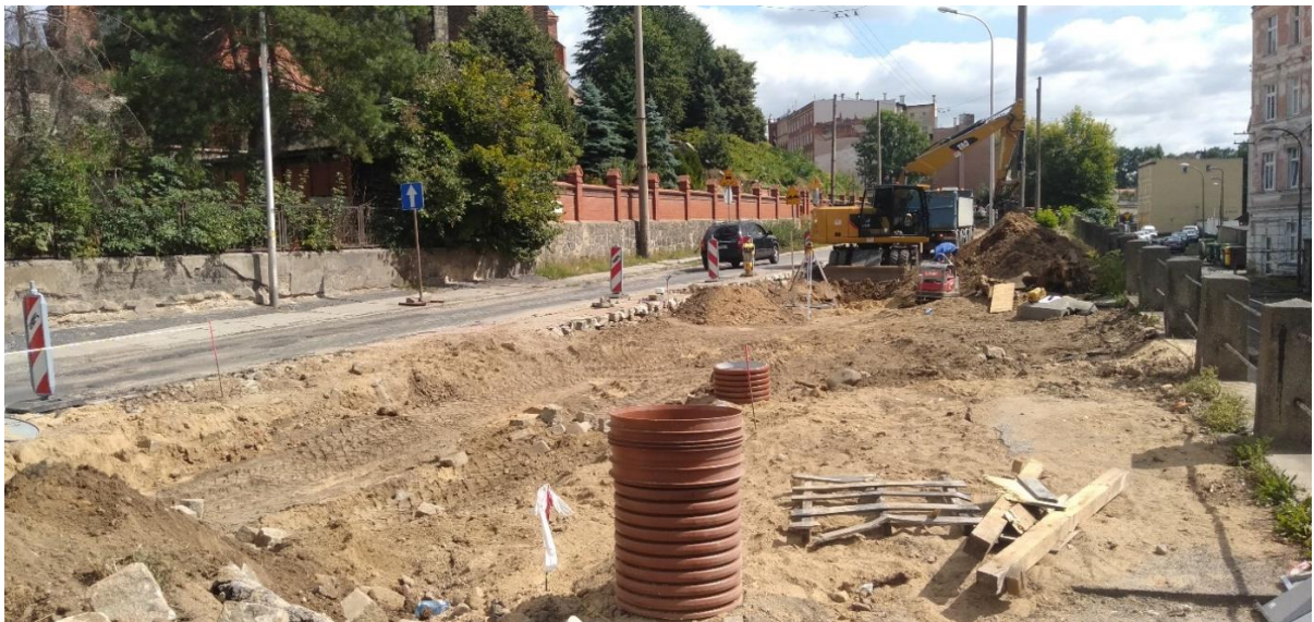
Prace budowlane – Sierpień 2021r.
