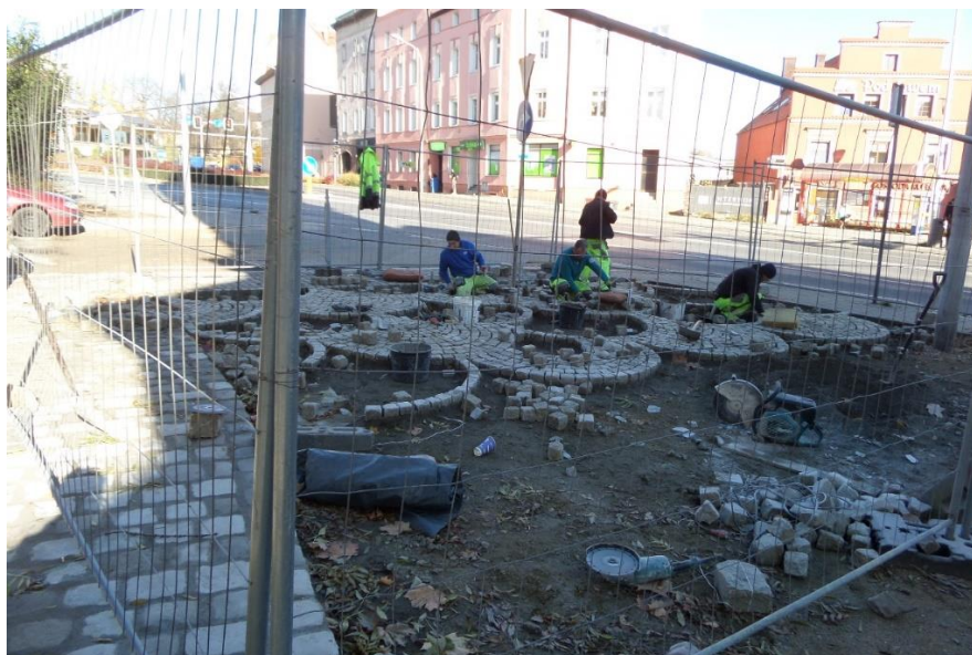
Prace budowlane – Listopad 2021 r.
