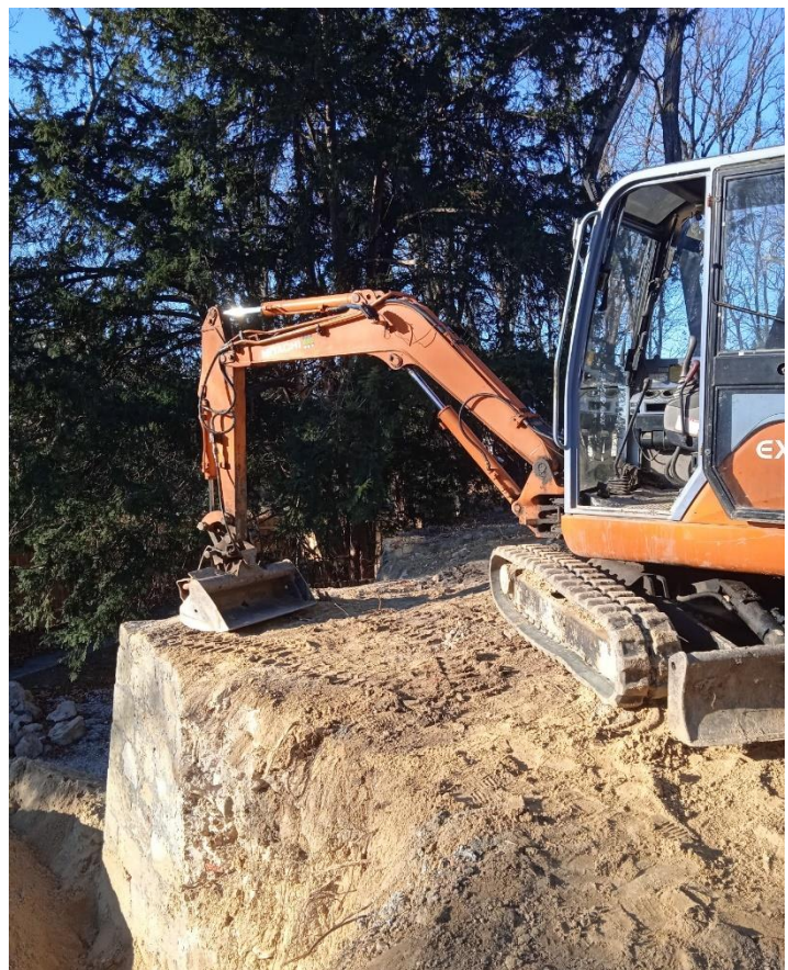
Roboty budowlane - grudzień 2021
