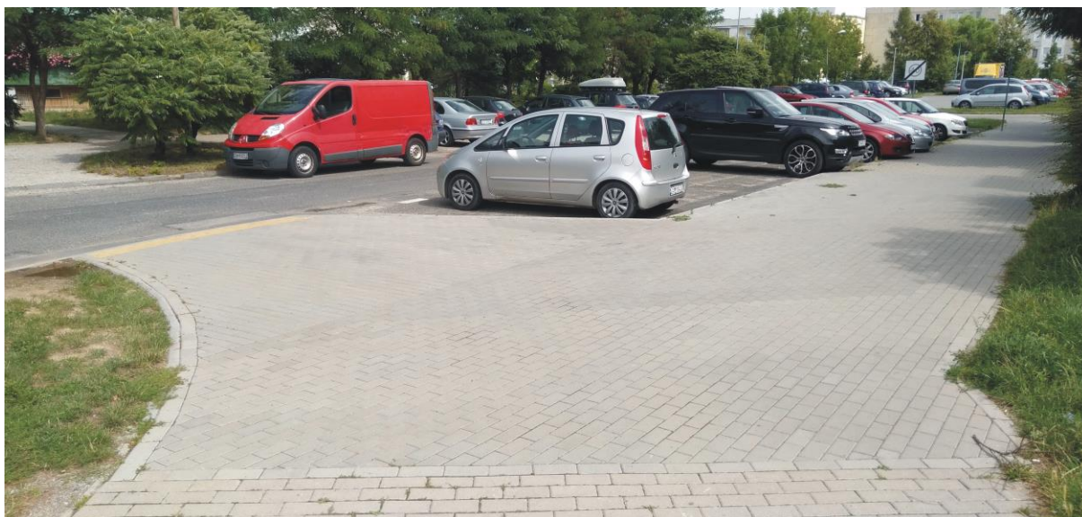
Nowa nawierzchnia chodnika przy ul. Niemcewicza
