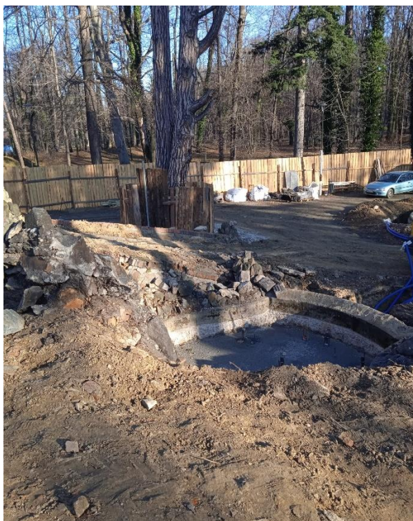
Roboty budowlane - grudzień 2021
