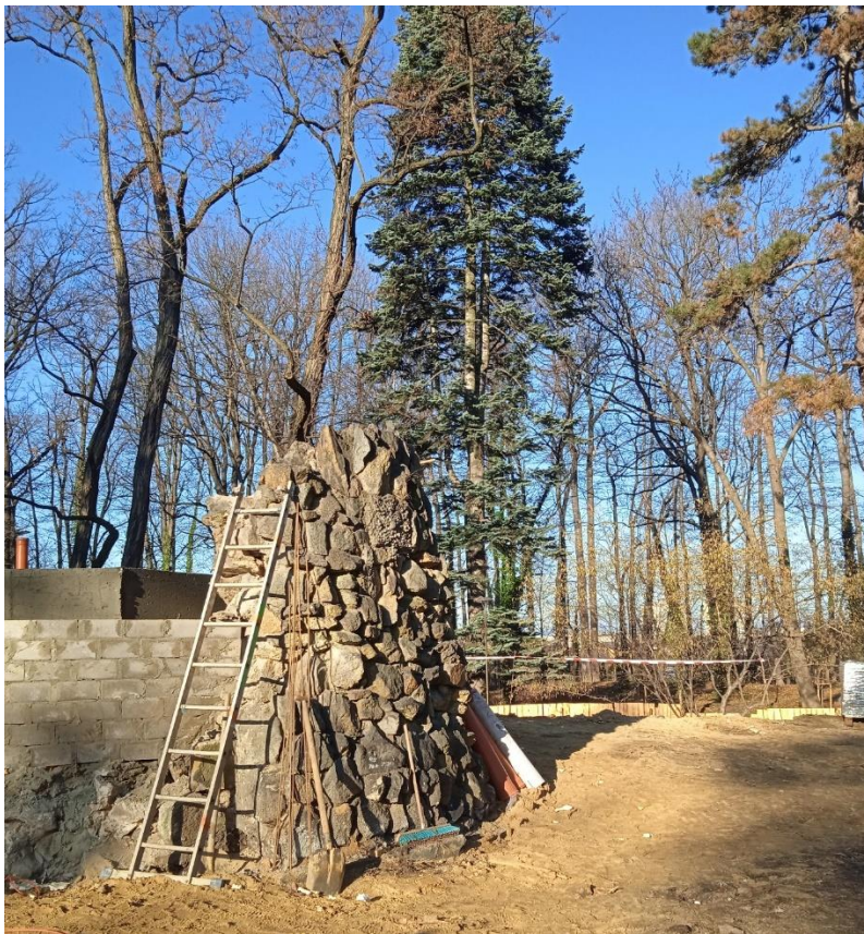
Roboty budowlane - grudzień 2021
