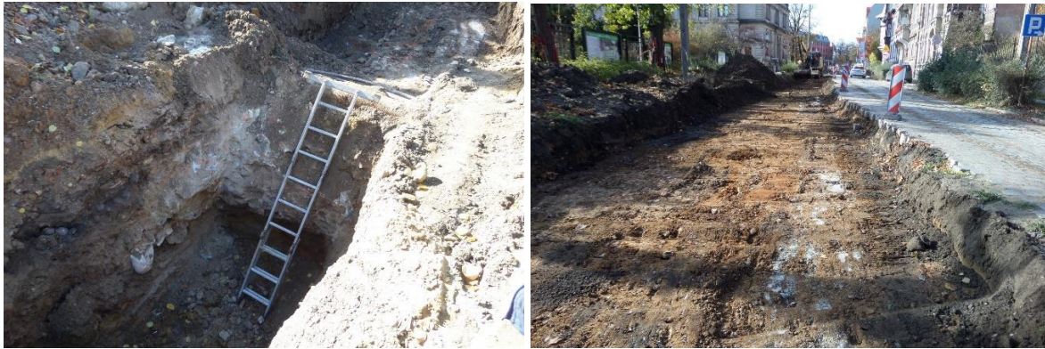
Prace budowlane – Listopad 2021 r.
