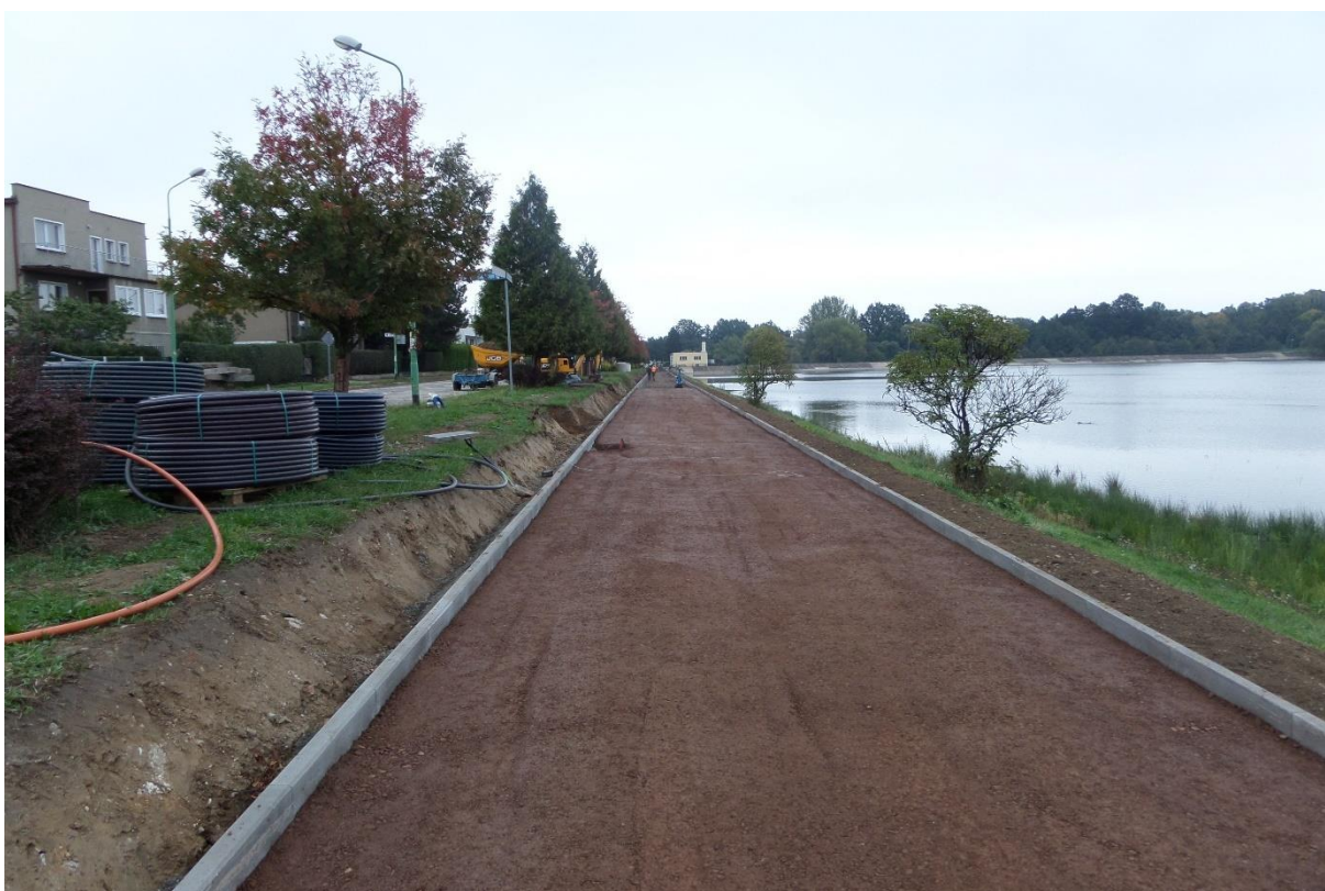
Prace budowlane – październik 2021 r.
