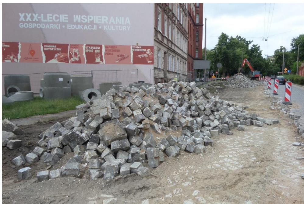
Prace budowlane – Lipiec 2021 r.
