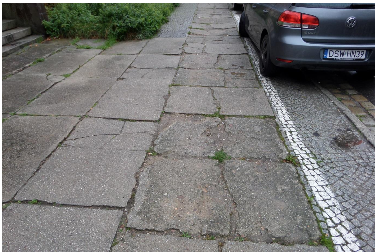
Chodnik wzdłuż ul. ks. Agnieszki przed przebudową
