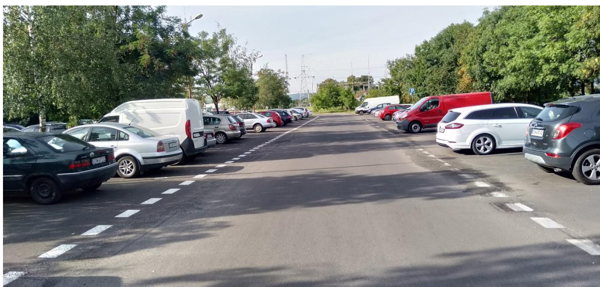
Wykonana wymiana warstwy ścieralnej ul. Prądzyńskiego
